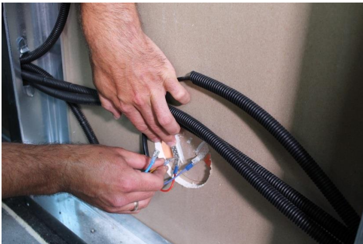
Abbildung 6: Verkabelung der Carbo e-Wall® Heizplatte, bei doppelter Beplankung, Verkabelung von hinten
