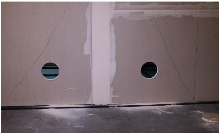
Abbildung 5: Hintere Platte mit Löchern für die Anschlüsse
