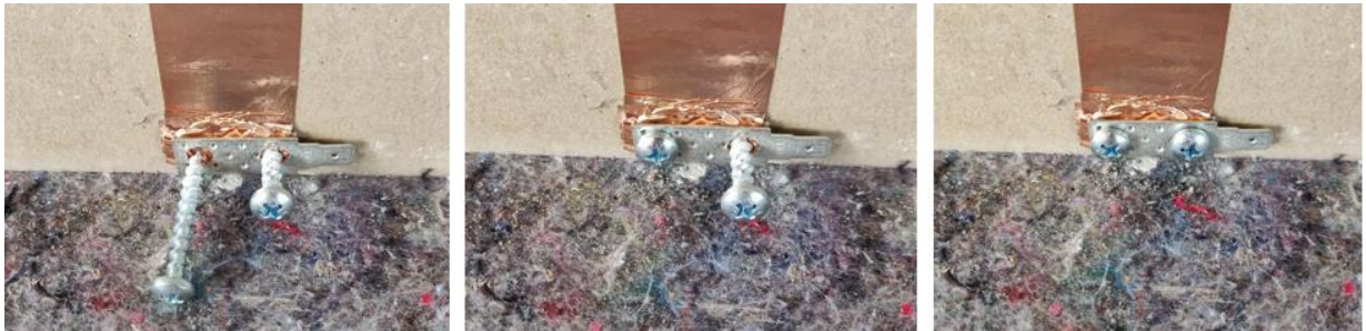
Abbildung 9: Eindrehen der Schrauben zur Befestigung der Crimps an der Wand
