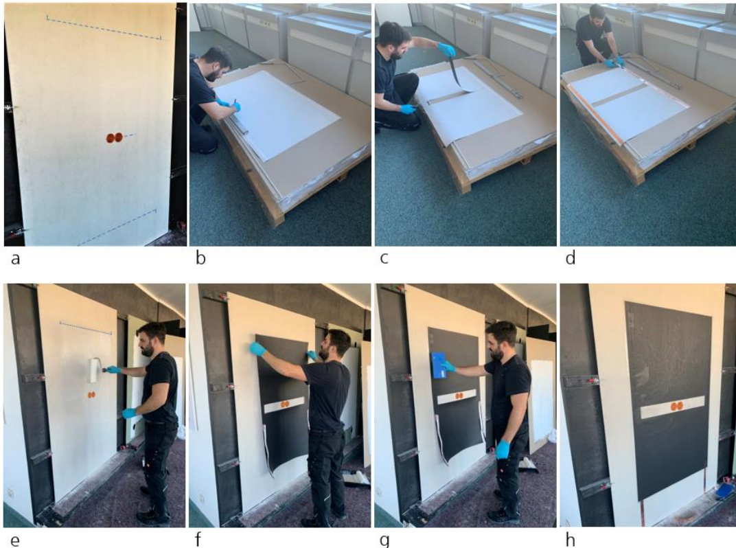
Abbildung 12: Installation der Carbo e-Now® Heizfläche mit AUsparung
