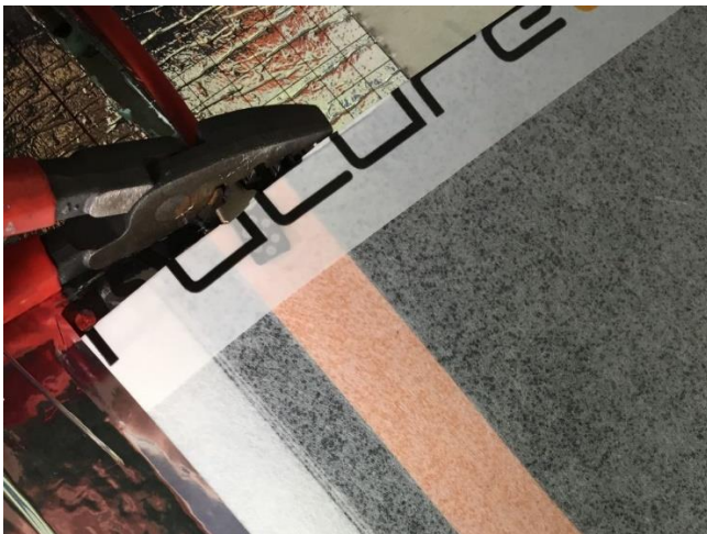
Abbildung 9: Befestigen des Kabels an der Heizfolie mittels Crimpzange
