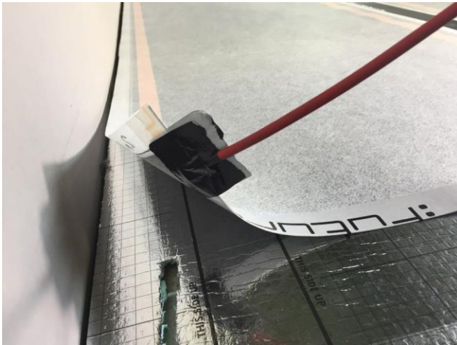
Abbildung 10: Isolieren der Crimp-Kontakte
