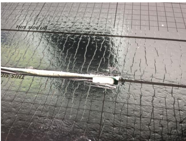
Abbildung 4: Einlegen des Bodensensors
