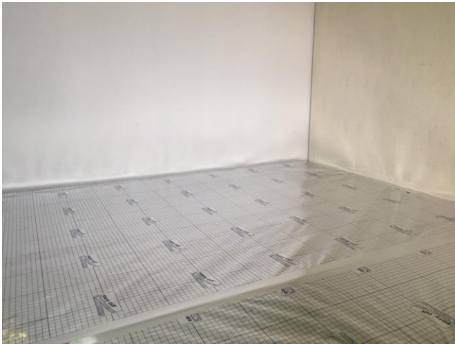
Abbildung 12: Einbringen der Wasserdampfdiffusionsperre und Abdichten mit Alu-Band
