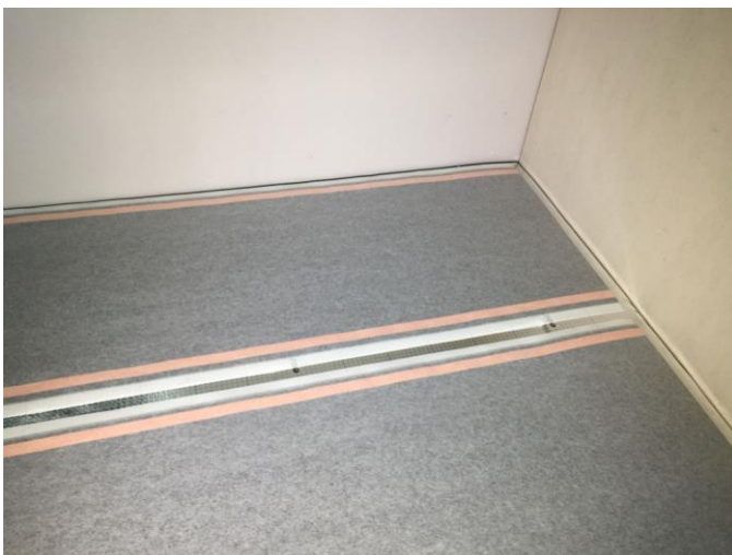
Abbildung 6: Verlegen der Carbo e-Foil Heizbahnen
