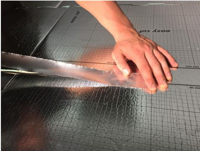
Abbildung 5: Abdichten der Schlitze und Stoßfugen mit Alu-Dichtband
