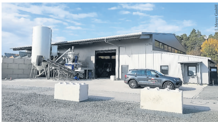
Die Büroräume befinden sich direkt neben einer großen Produktionshalle, in der Bauteile hergestellt werden.
